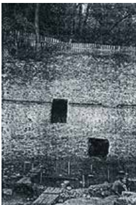
13 pav. Skylės šiaurinėje atraminėje Pilies kalno sienoje, 1957 m.
